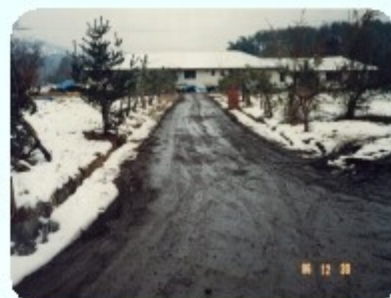
西側からみた正面玄関
