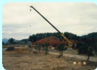
現在の1病棟の建築風景
